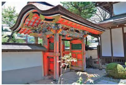
背側面の全景 屋根を側面から見たとき凸形曲線となっているのが「平唐門」である。中央に2本の丸柱を建て、その前後に断面が四角な控えの柱が建つ形式の門が「四脚門」。その両方の形式を持つこの門は「四脚平唐門」と称され、全国的にも珍しい。
