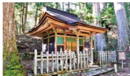
上杉謙信霊屋の全景 正面3間、側面2間、入母屋造り、向拝付き、檜皮葺の霊屋である。右手には空地があつて、かつてはそこに、養子「上杉景勝」の霊屋があつたようである。
