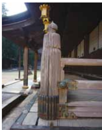
写真4 御影堂の高欄（昭和元年（1925）の火災の痕跡を留めています（写真左側は金堂側））
