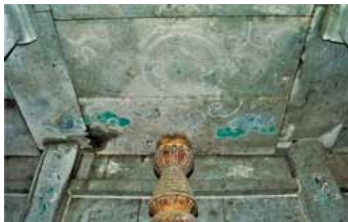
秀康霊屋の内部を見る 天井には天蓋が描かれ、四方に雲がたなびいている。柱や小壁にも彩色が残る。剥落しているがかつては華やかだったに違いない。中央に金色に輝く秀康の墓石の頂部が見える。
