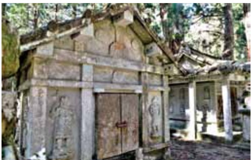
母の霊屋の正面を見る 中央に石製の扉を建て込み、扉上に阿弥陀如来を表す梵字が刻まれている。左右には仏像が浮き彫りに彫り出されている。右は不動明王、左は四天王の一つ増長天のようだ。
