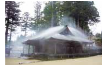
ドレンチャー放水のようす
