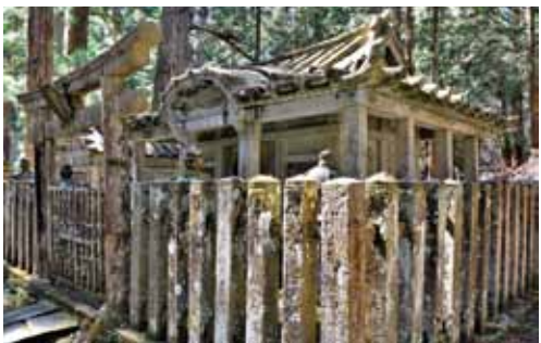
秀康の霊屋の正面の全景 建物は、扉と壁で閉ざされた「母屋」と、吹き放しの「庇(ひさし)」で構成され、入母屋屋根を架ける。正面中央間には、柱上に組物を置いて軒唐破風(のきからはふ)を付けている。
