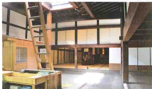
「明かり取り」の全景 明かり取りの上方は四方に軒が回っていて、本来中庭であることがわかる。床には簀の子が敷かれ、中央に水槽が据えられている。右手は台所と大主殿を繋ぐ渡り廊下で、かつては明かり取りとの間に建具が入っていた。写真奥は大主殿の土室の間。
