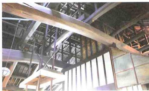
台所の小屋組 太い梁を縦横に架け渡し、その上に沢山の束を建てて屋根を支えている。中央に見える壁は煙出しで小屋組を突き抜け屋根の上に出る。
