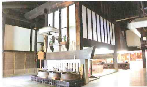
大釜と煙出し 台所の中央に三口の大釜が据えられている。焚口は煙出し側にある。右手端に小屋組から吊り下げられた棚が見えるが、鼠から食物を守る棚で、高野山独特の施設である。
